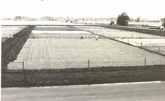
Aanleg proefveld in 1966
